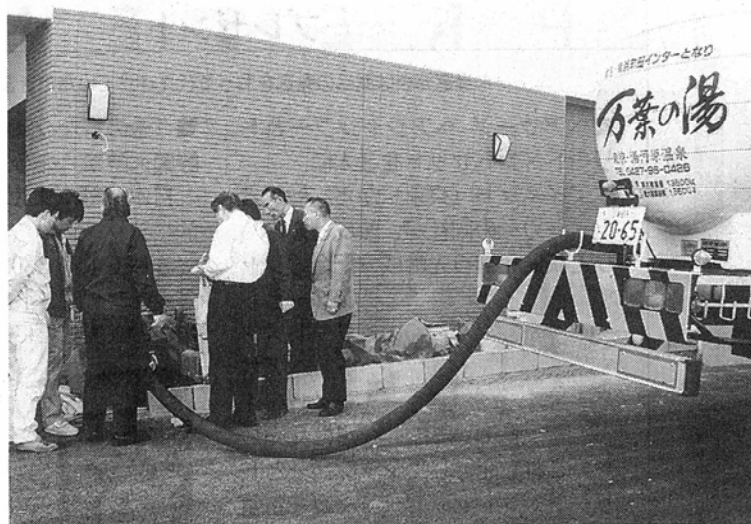
開業前、タンクトレーラーから町田「万葉の湯」の地下タンクに湯を移し入れる作業を試験的に実施 —1997年3月、東京都町田市
